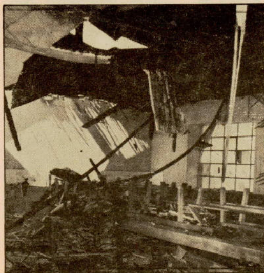
Las instalaciones del IER que servían a miles de campesinos han quedado inutilizadas por la acción de Sendero Luminoso.
